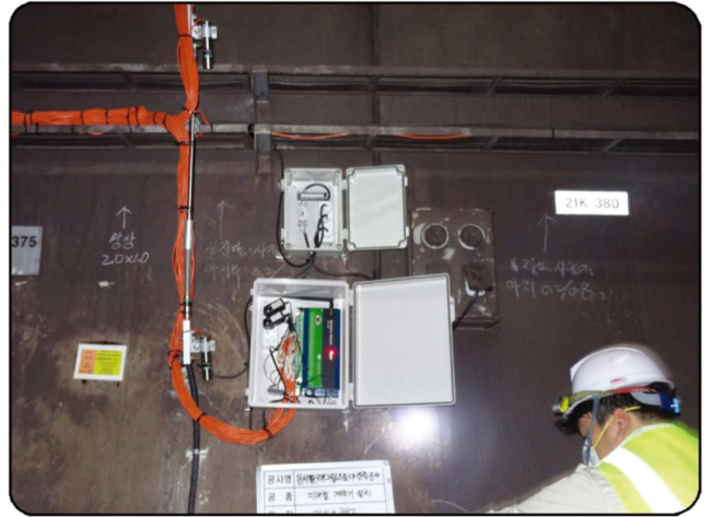
[ADL-16V 터널 설치 사진]
